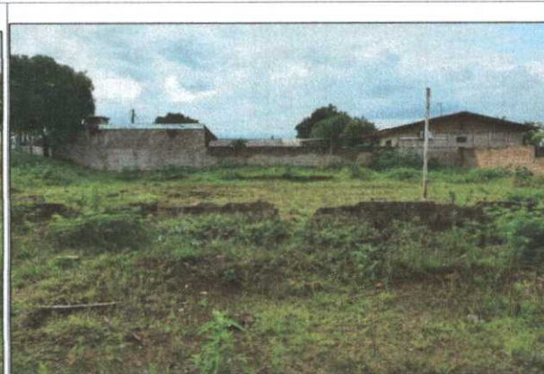
FOTO 2 - VISTA LATERAL DIREITA
